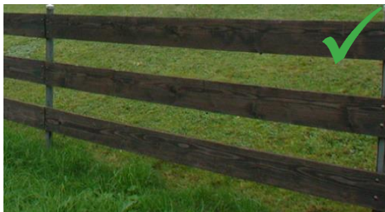
Exemple de barrière perméable à la petite faune
