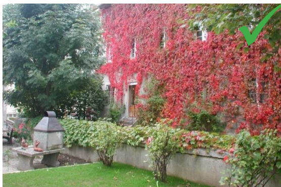
Exemple de façade et de mur végétalisés
