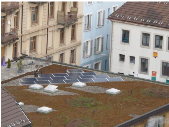
Exemple de toiture végétalisée avec panneaux solaires
