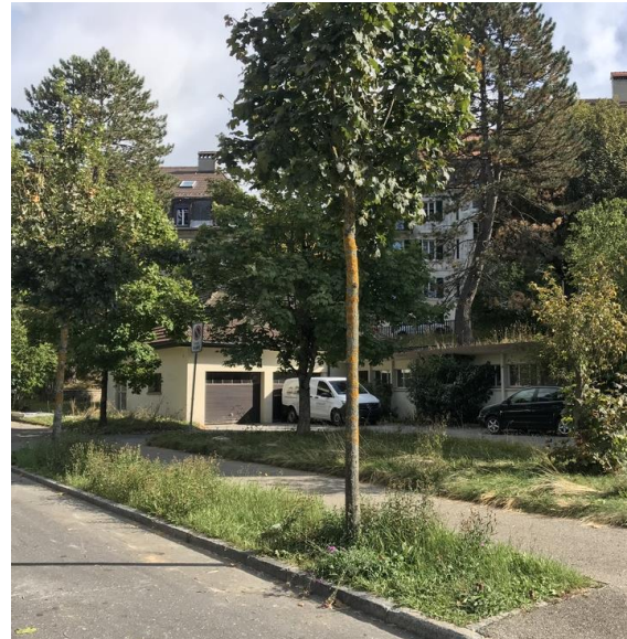
Fosse continue avec végétation au pied des arbres
