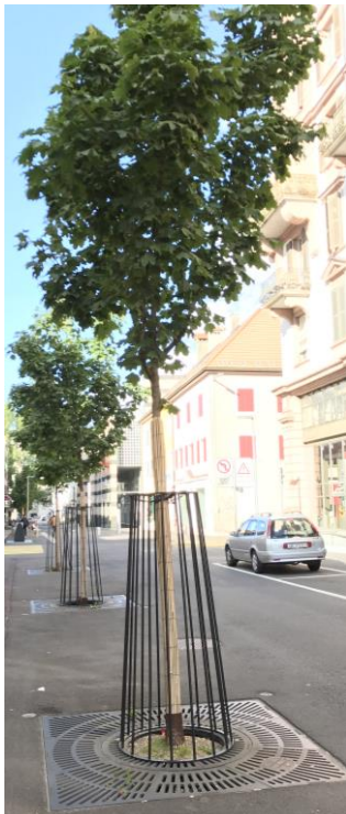
Jeune arbre à la plantation avec grille carrossable, protection métallique à la base du tronc et corset
