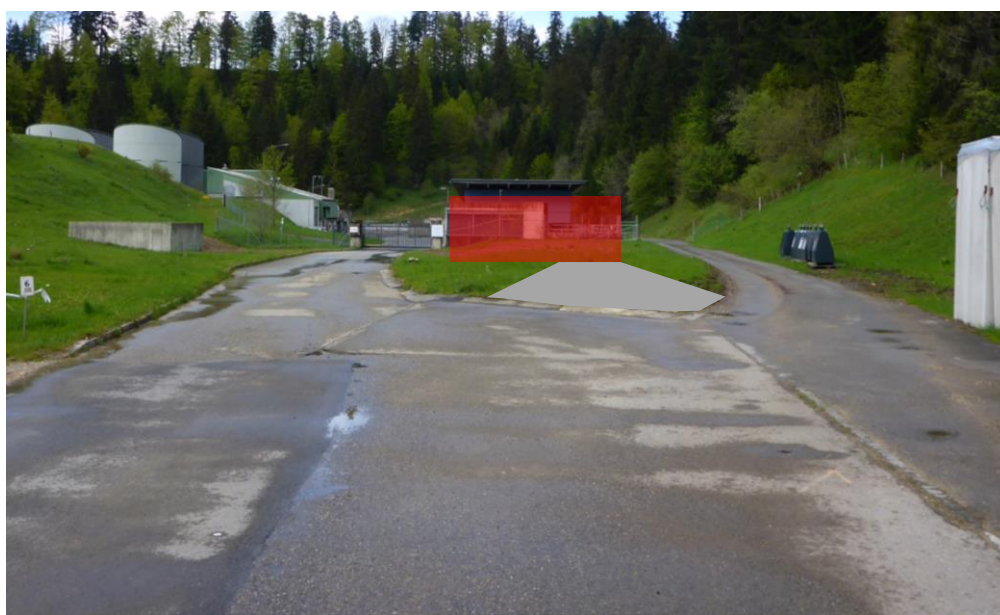
Figure 11 : Bâtiment projeté et accès, vu depuis la route d'accès à la STEP
