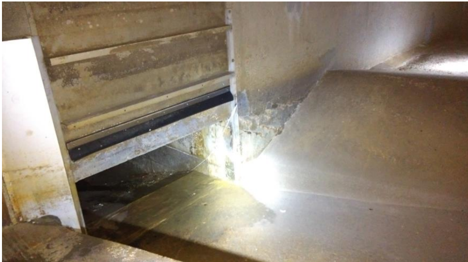
Figure 6 : Ouverture, avec batardeau
