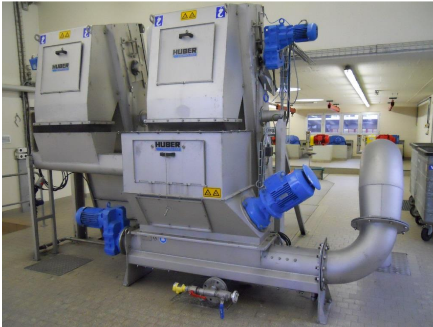
Figure 8 : Exemple de dégrilleur, partie haute située au-dessus du canal (Source : Huber)
