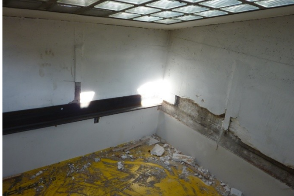
Profil métallique pour l'appui des nouvelles coupoles et dégagement de la tranche de dalle dans le puits de lumière est.
