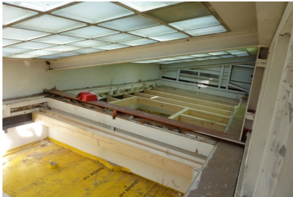
Structure porteuse des coupoles ouest Profil métallique fixé dans le bord de dalle Poutraison en bois.
