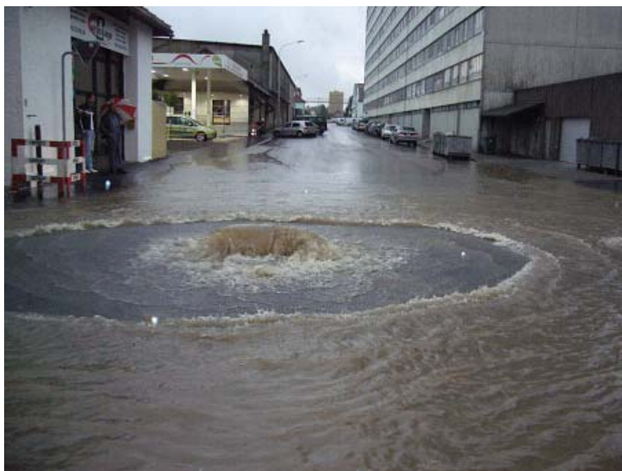
Photo 2 : Débordement collecteur en Ouest centre commercial, rue des Entrepôts
