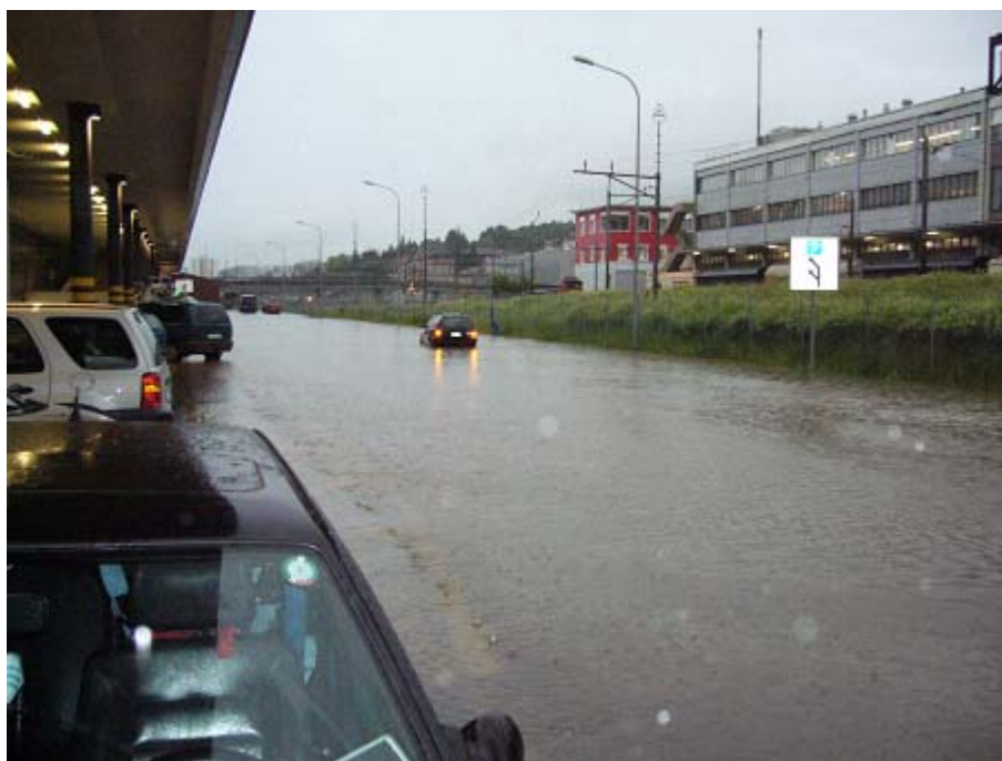
Photo 1 : Inondations 2006, secteur rue des Entrepôts
