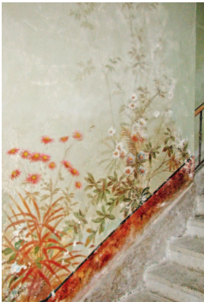
Ici, la cage d'escalier d'un immeuble de la rue des Tourelles, avant restauration. SP
