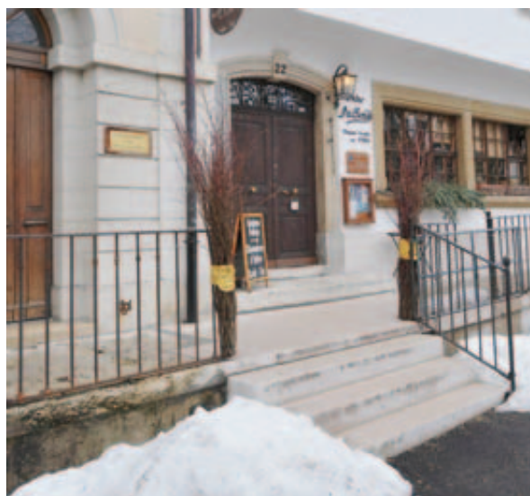
Exemple de rénovation soutenue par les autorités du Locle: celle du perron de la Maison Du Bois, dont la pierre de calcaire était fissurée. RICHARD LEUENBERGER
